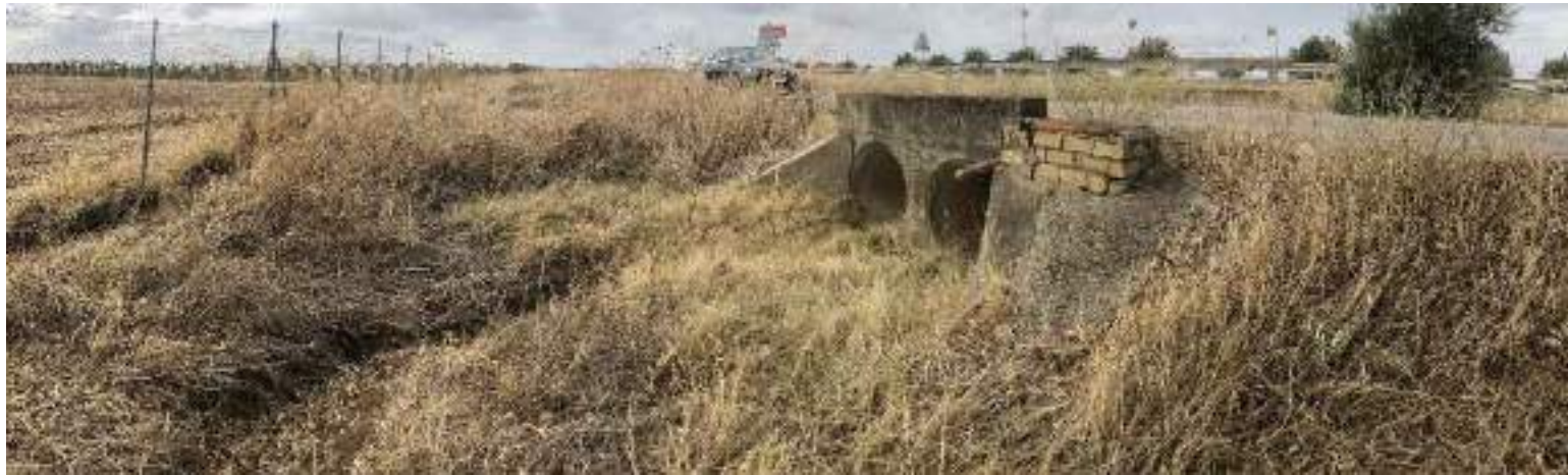
1. DETALLE ENCUENTRO CUNETA Y ALBINA INNOMINADA (ENTRADA CARRETERA)
