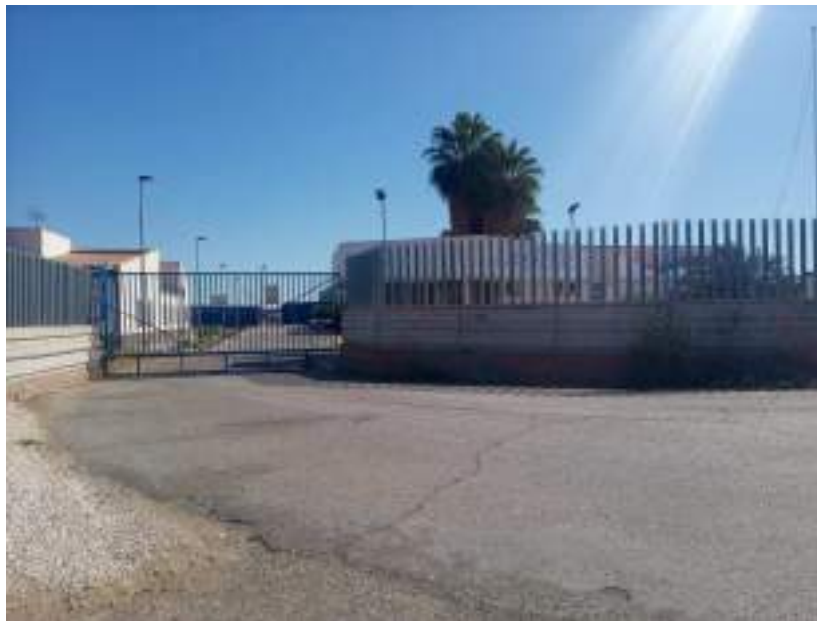
Foto 1. Estado Actual sector SU-NC-18
