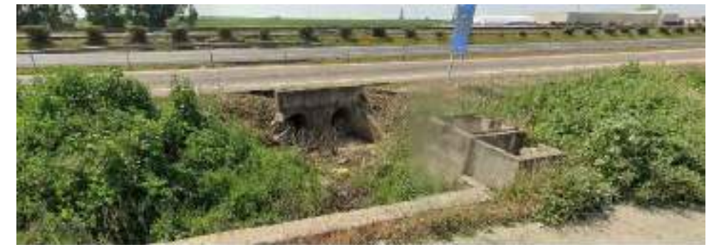
4.- DETALLE SALIDA DE ALBINA INNOMINADA BAJO AUTOVIA ( SALIDA DE LA ALBINA )
