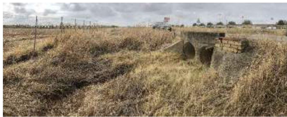
UNION DE CUNETAS A ALBINA INNOMINADA BAJO VIALES (EMBOCADURAS)
