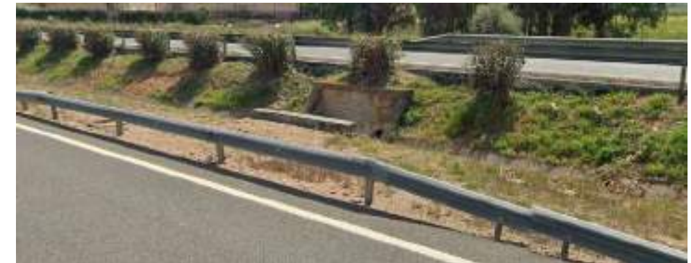
3.- DETALLE DE ALBINA INNOMINADA PASO BAJO AUTOVIA DE ANDALUCIA (MEDIANA)
